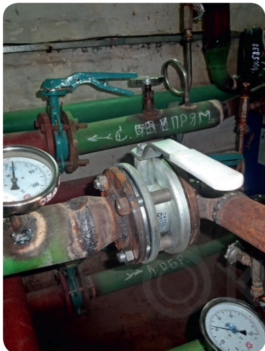
ТЕПЛОПУНКТ (ОБВЯЗКА ТЕПЛООБМЕННИКА)
