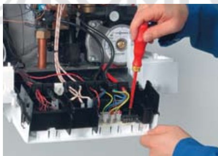
3. Подключение электрических присоединений
