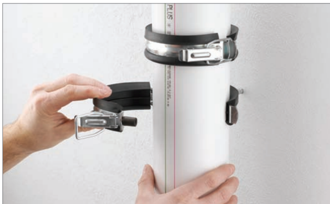
Рис. 8-2 Установка трубы
