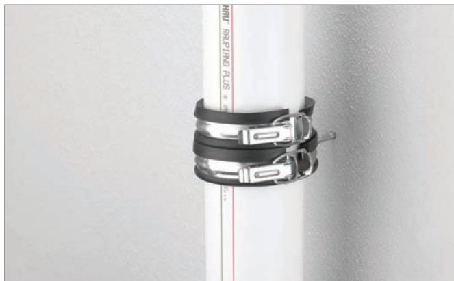
Рис. 8-3 Шумопоглощающий хомут в смонтированном состоянии
