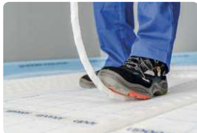
Просто прижмите трубу подошвой к поверхности панели
