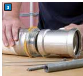
**3** **Соединение пресс-модуля с базовой деталью**
