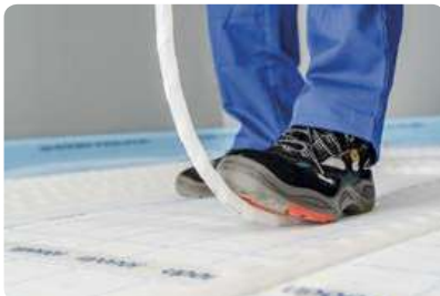
Просто прижмите трубу подошвой к поверхности панели
