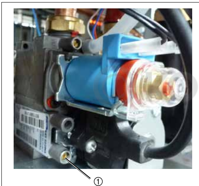
Рис. Комбинированный газовый клапан
