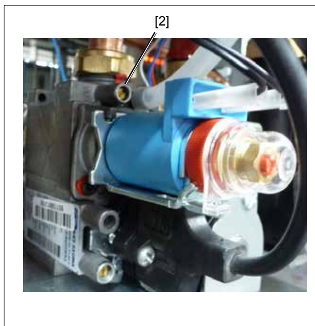
Рис. Штуцер для измерения давления в сопле
