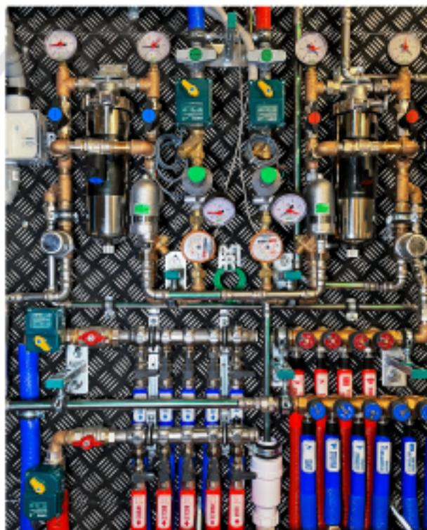
Обшивка технологических ниш и помещений алюминиевым листом избавляет от подготовки поверхности стен штукатурно-малярными работами, чем сокращает время монтажа. Готовый узел отопления и водоснабжения выглядит технологично и стильно.
