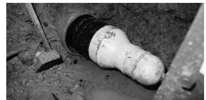
Рис. 11.2 Фотография носового конуса, приваренного стыковой сваркой
