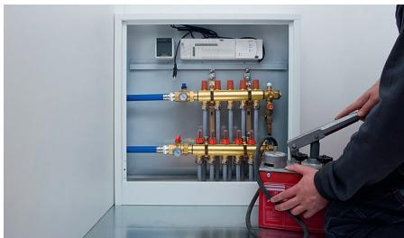
**Рис. 5.** Проведите испытание давлением в соответствии с протоколом испытаний.
