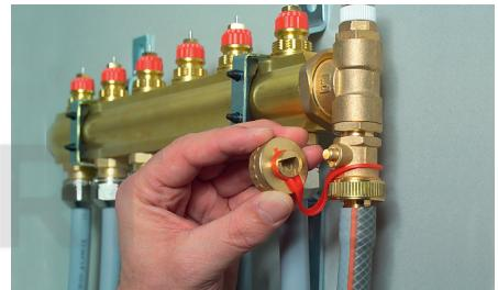
**Рис. 3.** Подающий и обратный коллекторы оснащены кранами для заполнения и слива теплоносителя.
