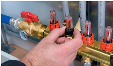
**Рис. 4.** Полностью откройте шаровые краны и расходомеры.
