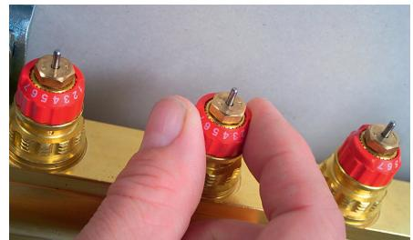
**Рис. 6.** Выставьте преднастройку на клапанных вставках в соответствии с расчетом и техническим описание на коллекторы.
