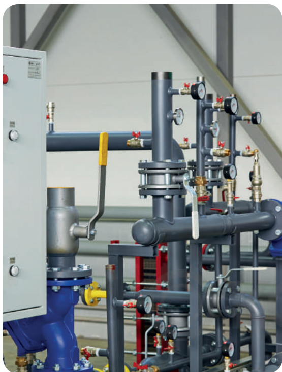
ИНДИВИДУАЛЬНЫЙ ТЕПЛОВОЙ ПУНКТ
