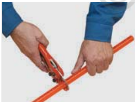
■ Отрезание трубы при помощи ножниц.
