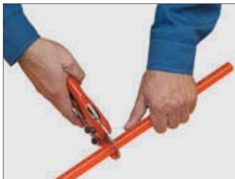
■ Отрезание трубы при помощи ножниц.
