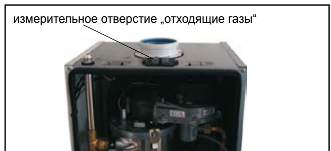
Рис.: Измерение отходящих газов на открытом котле
