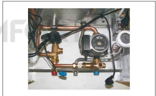
Рис.: Блок подключения демонтирован
