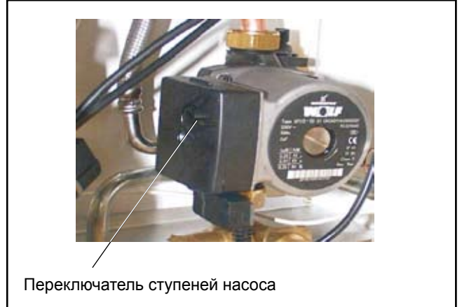
Рис: Переключатель ступеней на насосе котлового контура
