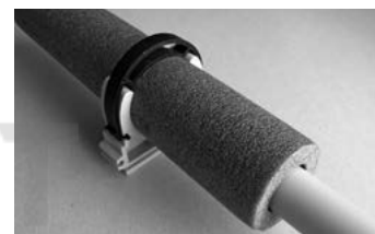
Для горячей воды поверх изоляции устанавливается хомут на размер больше
