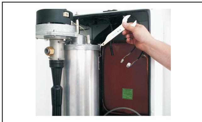
– Снять вверх крышку камеры сгорания.
