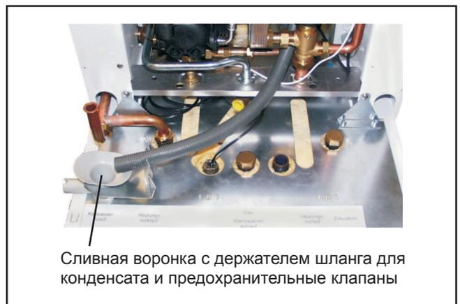
Рис.: Сливная воронка (принадлежности)
