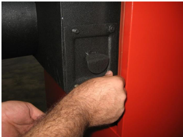
Рис. 9. Снятие заглушки для чистки адаптера дымохода.
