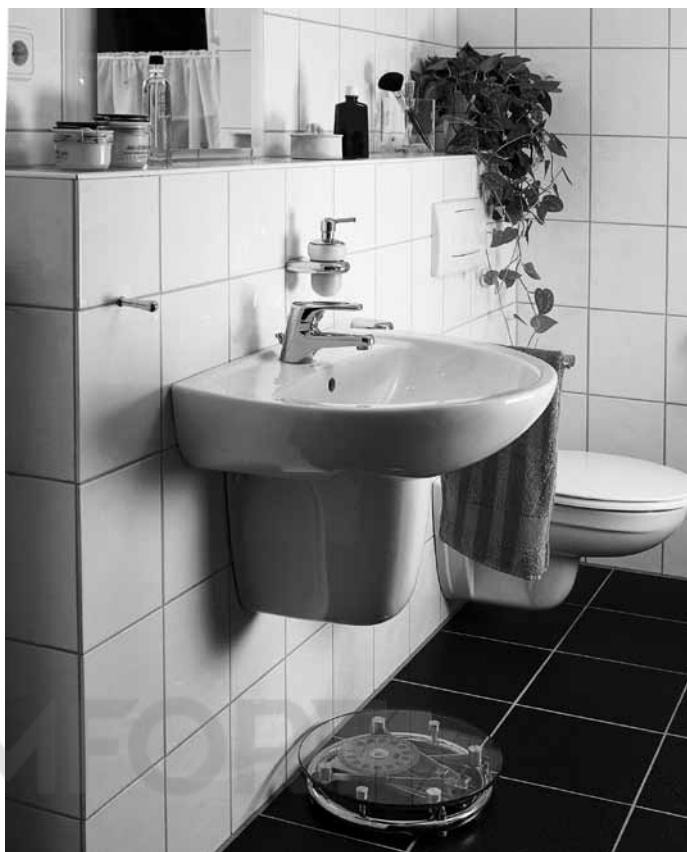
Завершенная перегородка с санфаянсом
