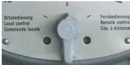
рис. М-6: Ключ-селектор на пульте местного управления
