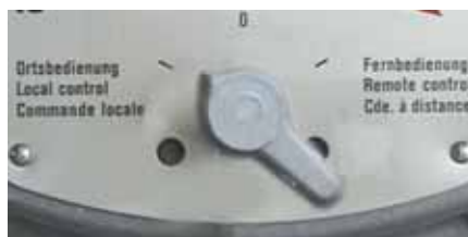
рис. М-3: Ключ-селектор на пульте местного управления
