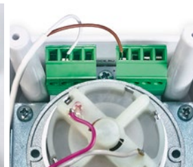
Фото 11. Подключение датчика к электроприводу
