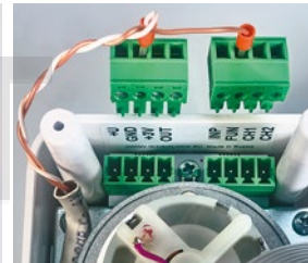
Фото 18. Подключение проводного выключателя к электроприводу
