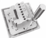
Рисунок 5. Демонтаж лицевой панели
