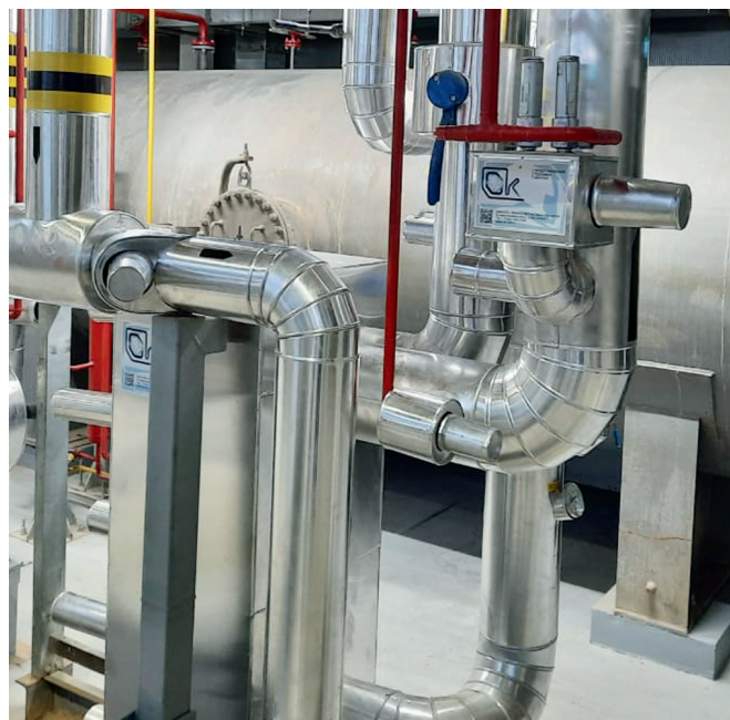
Рис. 4. Полуварной пластинчатый испаритель Danfoss SW в теплоизоляции
