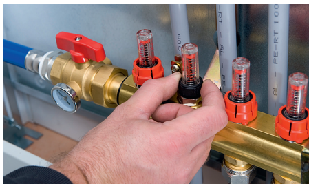
Рис. 4. Полностью откройте шаровые краны и расходомеры.
