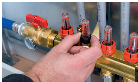
Рис. 4. Полностью откройте шаровые краны и расходомеры.
