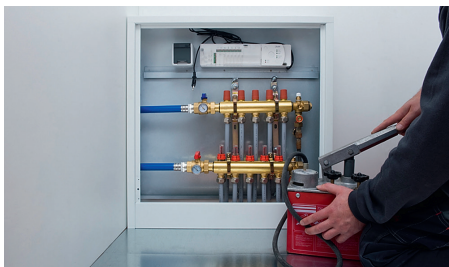
Рис. 5. Проведите испытание давлением в соответствии с протоколом испытаний.
