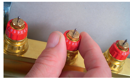
Рис. 6. Выставьте преднастройку на клапанных вставках в соответствии с расчетом и техническим описанием на коллекторы.
