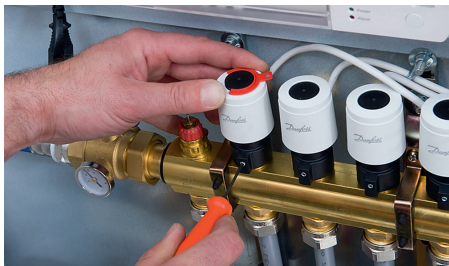
Рис. 7. Смонтируйте электроприводы на клапанные вставки и зафиксируйте их с помощью 2 мм шестигранного ключа.. Подключите приводы к коммутационной панели.
