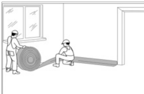
Рис.20. Раскладка под стеной краевой ленты.
