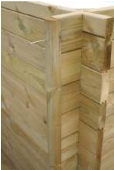
Рисунок 20 – Деревянные накладки
