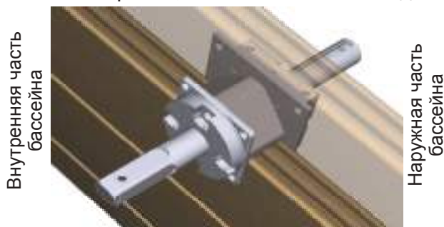
Рисунок 39 – Установка вала автоматического покрытия
