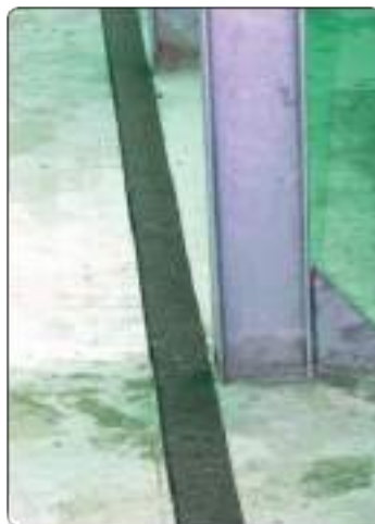
Рисунок 8 – Установка битумных полос
