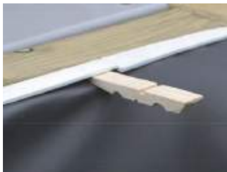
Figure 31 – Фиксация лайнера с помощью половинки прищепки
