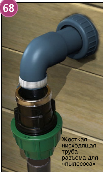
Жесткая нисходящая труба возвратной форсунки
