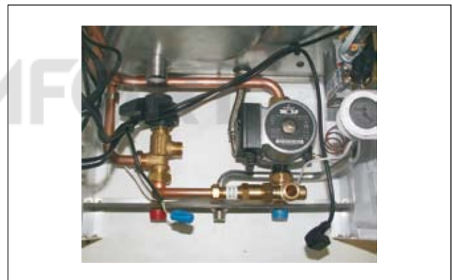
Рис.: Блок подключения демонтирован
